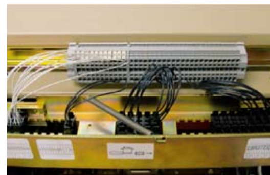
所有的Masterpact NW二次端子都是预接线系统，客户仅需根据现有M断路器的配置选择相应的NW 附件
